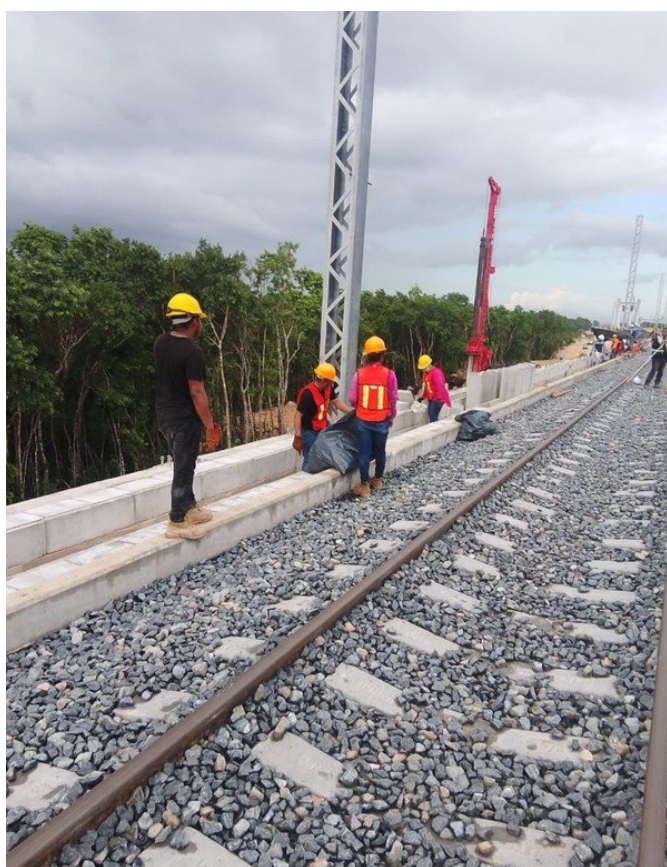
Montaje de postes metálicos para catenaria.
