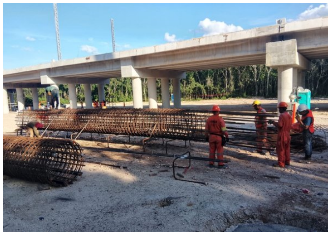
Armado de acero para elementos de subestructura.
